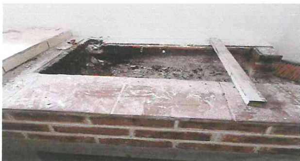
Foto 5: Sustitución de plancha de metal
