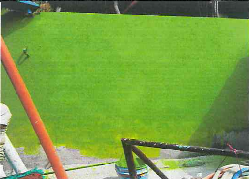
Foto 1: reparación de repello, cernido y pintura en paredes interiores y exteriores de todo el establecimiento
